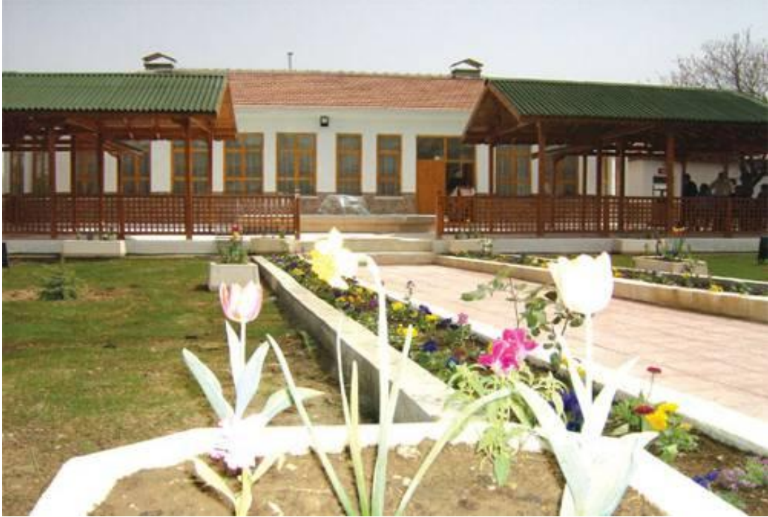
Bozüyük Açık Ceza İnfaz Kurumu İşyurdu Müdürlüğü Uygulamalı Sosyal Tesisi,
